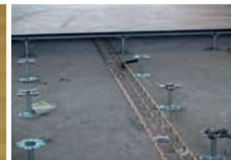
Montaje de estructura suelo técnico (pedestales).
