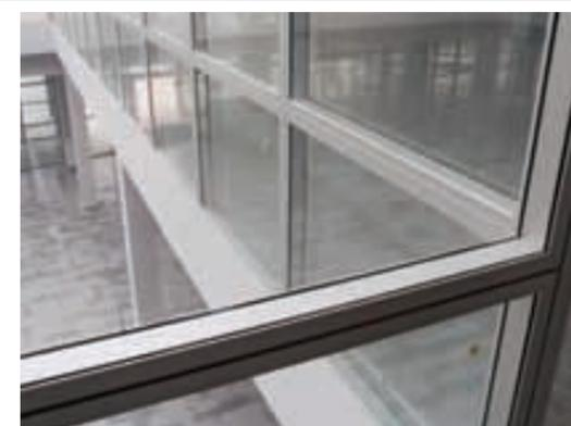
Entrecalle de perifería cubierta por tapeta y lambeta en cara exterior e interior respectivamente.
